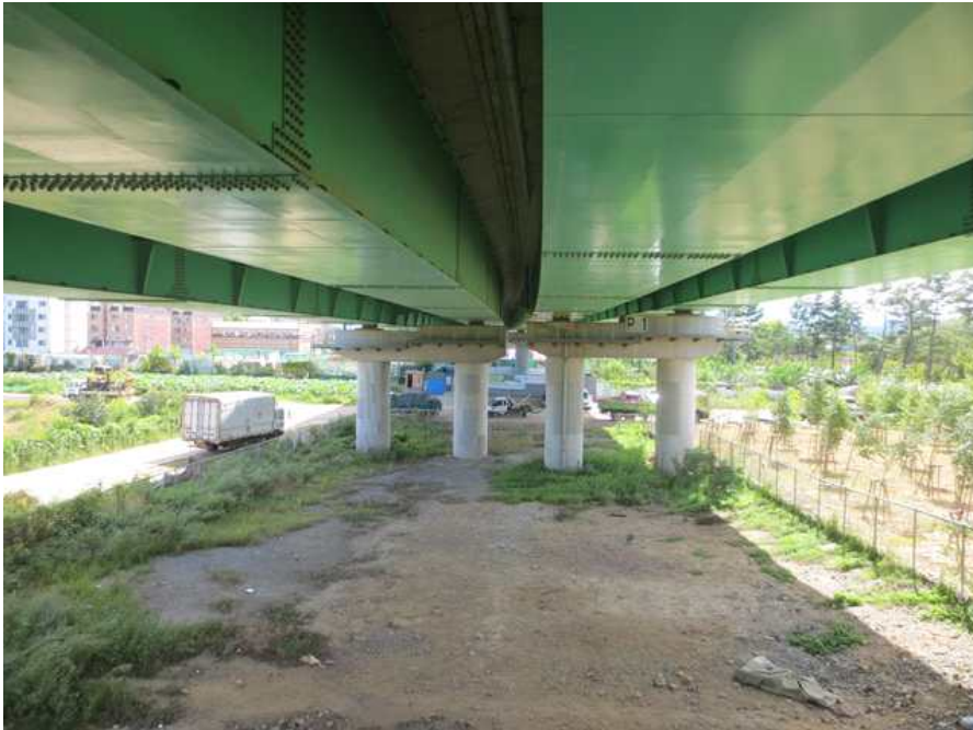
바닥판하면 및 강박스 외부전경
